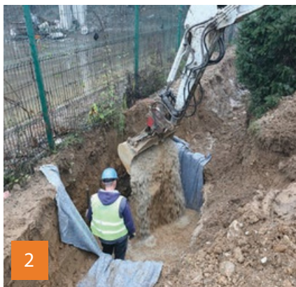
Nasipanje materiala za posteljico jaška.
