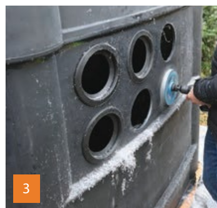
Izvedba priključkov na jašek.
