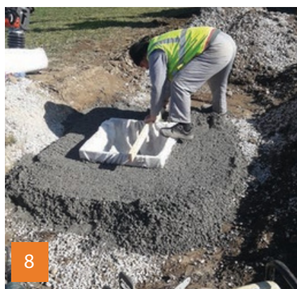
Priprava in niveliranje betonske podlage za AB venec s pokrovom.
