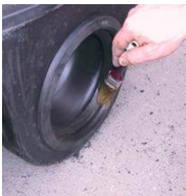
Mazanje vstopnega tesnila in PVC cevi
