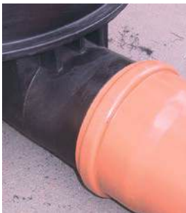
Priključitev PVC cevi
