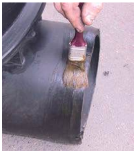
Mazanje roba stopničastega nastavka...
