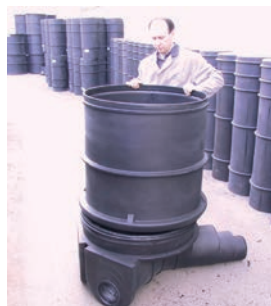
Namestitev telesa jaška in odrez roba
