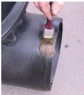
Mazanje roba stopničastega nastavka...
