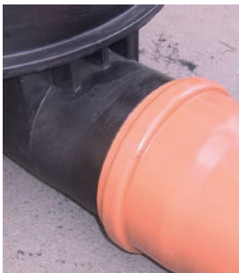
Priključitev PVC cevi
