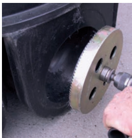
Vrtanje vstopne izvrtine z ustreznim kronskim svrdrom, adapterjem in ročnim vrtalnim strojem
