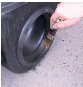
Mazanje vstopnega tesnila in PVC cevi
