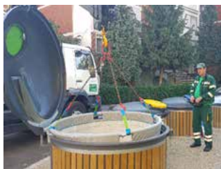
Slika 8: priklop kavlja na bremenske trakove
